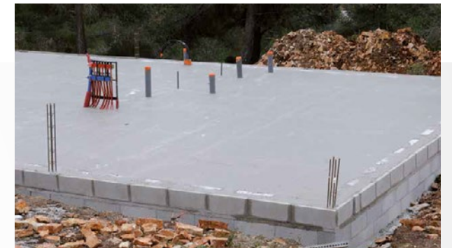
■ Déverser et vibrer le béton de façon uniforme à partir des appuis vers le centre, pour éviter toute concentration de poids.
