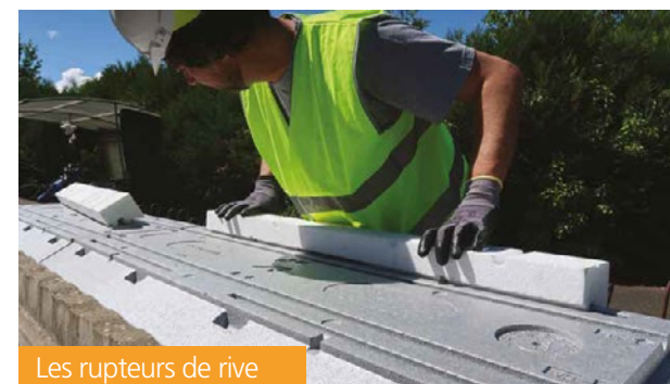
Les rupteurs d'about
