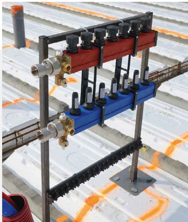
■ Fixation des collecteurs sur les 2 traverses hautes à l'aide de colliers de serrage.
