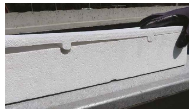
■ Sur les zones de portes et baies vitrées qui nécessitent la pose d'un seuil : 1 - Enlever la rehausse du Thermosten 2 - Fixer la cornière avec les pointes d'ancrage fournies Ainsi le seuil est encastré dans le chaînage (réservation 16 mm).
