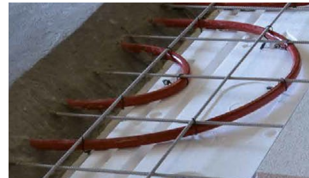
■ Le treillis et les tubes sont directement intégrés dans la dalle de compression.
